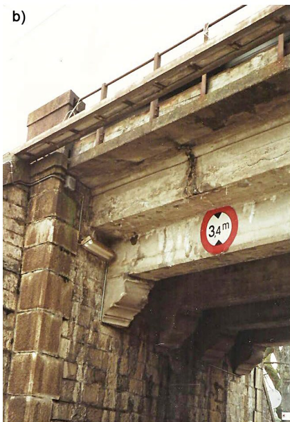
Bild 1 Straßenunterführung „Creux-du-Mas“ (1897), erste Bahnbrücke in der Schweiz aus Eisenbeton: a) Ansicht, b) Detail (Fotos von 1996, E. BRÜHWILER) Road underpass „Creux-du-Mas“ (1897), first railway bridge in Switzerland in reinforced concrete: a) view, b) detail (Photos from 1996, E. BRÜHWILER)
