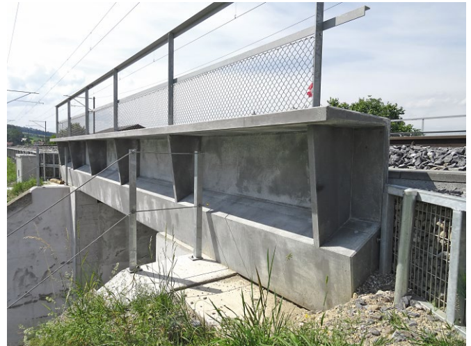
Bild 7 Seitenansicht des Randträgers aus bewehrtem UHFB Side view of the edge girder in reinforced UHPFRC
