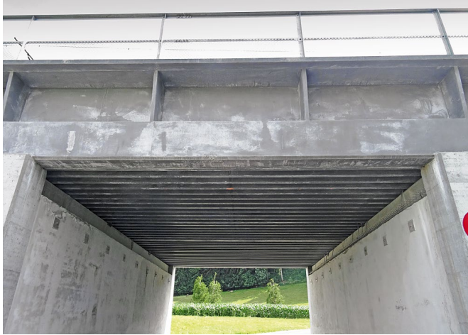
Bild 4 Randträger und Rippenplatte des Tragwerks aus bewehrtem UHFB Edge girder and ribbed plate of the structure in reinforced UHPFRC
