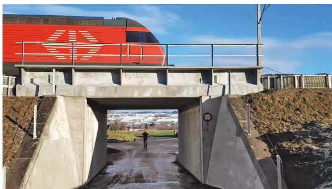
Bild 3 Straßenunterführung Unterwalden nach Abschluss der Bauausführung (Dezember 2017) Road underpass Unterwalden after construction (December 2017)
